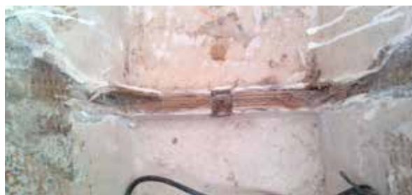
Främre skottet bortsågat. Sista bitarna av plywooden togs bort med hammare och stämjärn. Man ser att översta 10 cm släppt från skrovet.
