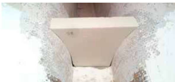
Distansmaterialet till det aktere skottet före plastning.
